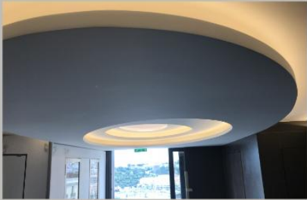
» Soffite en arondi et sur mesure, Spa de l'Hôtel de Paris, Monaco
